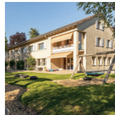
Kita In den Neumatten, Basel
