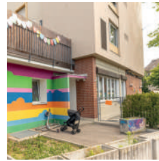
Kita Flughafenstrasse, Basel
