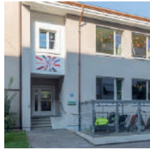
Kita Appenzellerstrasse, Basel
